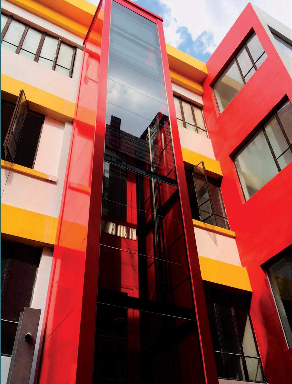
En extérieur, afin d'éviter que le soleil ne chauffe la gaine et la cabine, ERMHES propose l'option verre Stopsol qui permet de stopper les rayons du soleil. Nous proposons également l'option VMC qui permet de ventiler l'air à l'intérieur de la gaine et donc de la cabine. Ces deux options permettent d'avoir une température agréable même en cas de forte chaleur comme dans la photo ci-dessus à Manille (Philippines).
